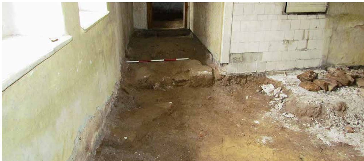
Obr. 6. Plzeň-Bolevec, selský statek U Matoušů čp. 1. Nález kamenných základů východní zdi v severovýchodním rohu pozdější kuchyně. (Foto F. Kasl, 2020)
