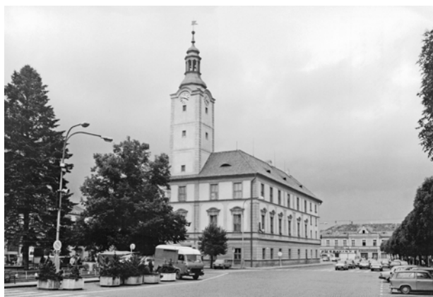
Obr. 3. Sušice, radnice čp. 1. Původní radnice byla zničena při velkém požáru v roce 1707. Stávající budova vznikla přestavbou v letech 1850–1851. (Foto J. Gryc, 1989)
