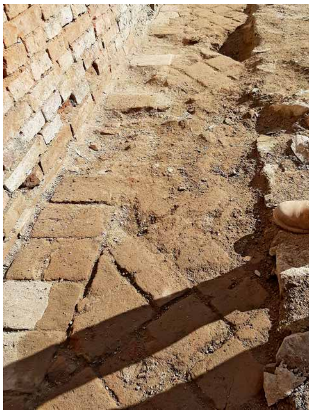
Obr. 3. Kladruby, klášter. Rajský dvůr starého konventu, náleží původní, patrně raně barokní cihelné dlažby někdejšího severního ambitu – dlažba byla obnovena jako replika v nové vrstvě. Stav v říjnu 2020. (Foto M. Zemanová, 2020)
