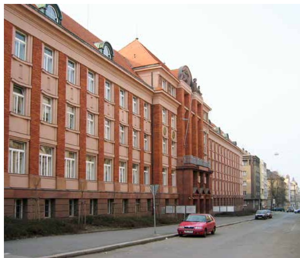
Obr. 3. Plzeň, Škroupova ul. čp. 1760, sídlo Krajského úřadu Plzeňského kraje, původně budova finančních úřadů, tzv. Rašínův dům, který byl vystavěn v letech 1924–1927 podle návrhu architekta Františka Roitha. (Foto P. Domanický, 2003)
