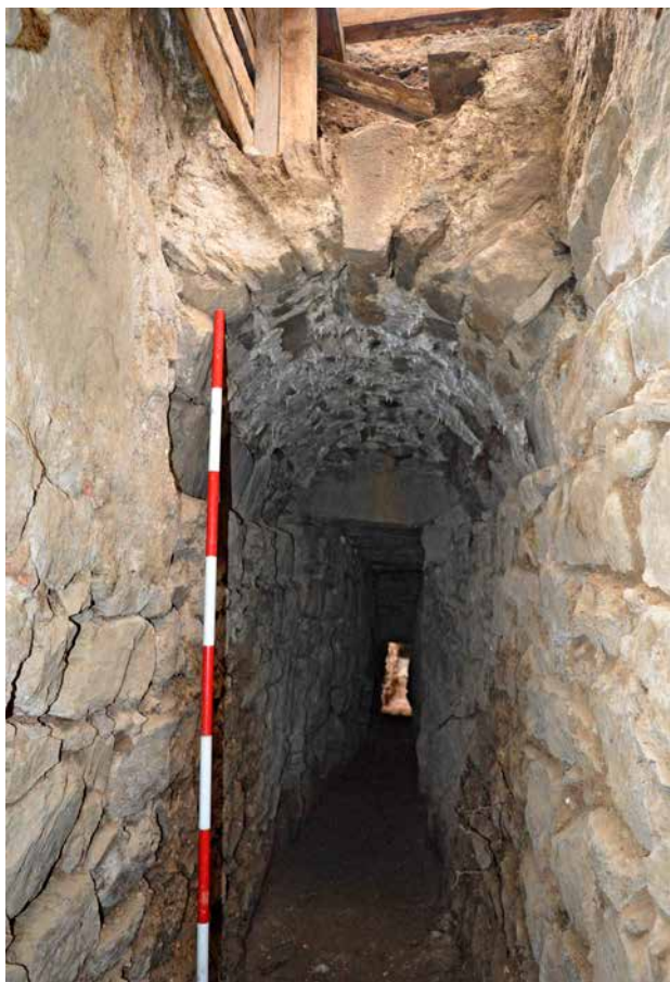
Obr. 6. Plasy, klášter, štol Q, šachta Š3. Pohled od severu – v průhledu patrná změna zastropení z klenby v rovný překlád. Nahoře patrná úprava koruny zdíva – žlabovitý útvar nad klenbou. (Foto M. Waldmannová, 2019)
