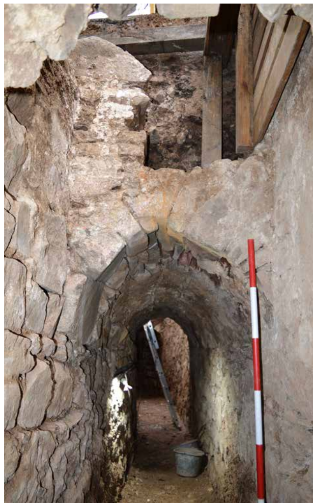
Obr. 24. Plasy, klášter, štola Q. Šachta Š3, žlabovitý útvar na koruně zdiva severní stěny šachty (vpravo nahoře), pohled od jihu. (Foto M. Waldmannová, 2019)
