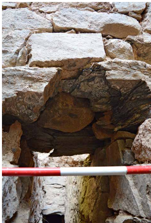
Obr. 11. Plasy, klášter, štola Q. Detail druhotně zaslepeného otvoru – dutiny – ve zdivu nad kanálem. (Foto M. Waldmannová, 2019)
