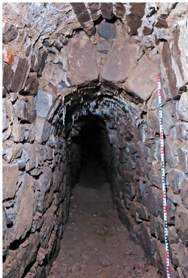
Obr. 28. Plasy, klášter, štola Q. Konstruktivní detail chodby Q1 – zvýšení klenby. Užití tesaných kvádrů, tzv. „klenáků“. Pohled od jihu. (Foto T. Karel, 2018)
