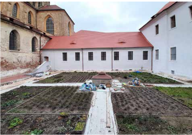
Obr. 13. Kladruby, klášter. Obnova rajského dvora starého konventu - stav v listopadu 2021. (Foto M. Zemanová, 2021)
