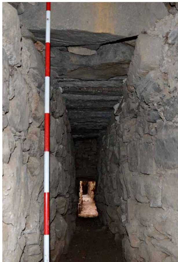
Obr. 7. Plasy, klášter, štol Q. Počáteční úsek kanálu – první dva překlady jsou dochovány in situ, zbývající byly doplněny v roce 2018. V zadní části snímku patrné čelo konstrukce se sníženou výškou stropu. (Foto M. Waldmannová, 2019)
