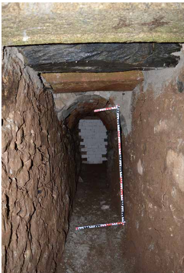
Obr. 13. Plasy, klášter, štola Q. Pohled na poslední zachycený úsek u jižního nároží sýpky, pohled od severu, po stavebním zajištění v roce 2020. Za cihlovou klenbou byla štola zasypaná, pravděpodobně však pokračuje jihovýchodním směrem. (Foto M. Waldmannová, 2020)
