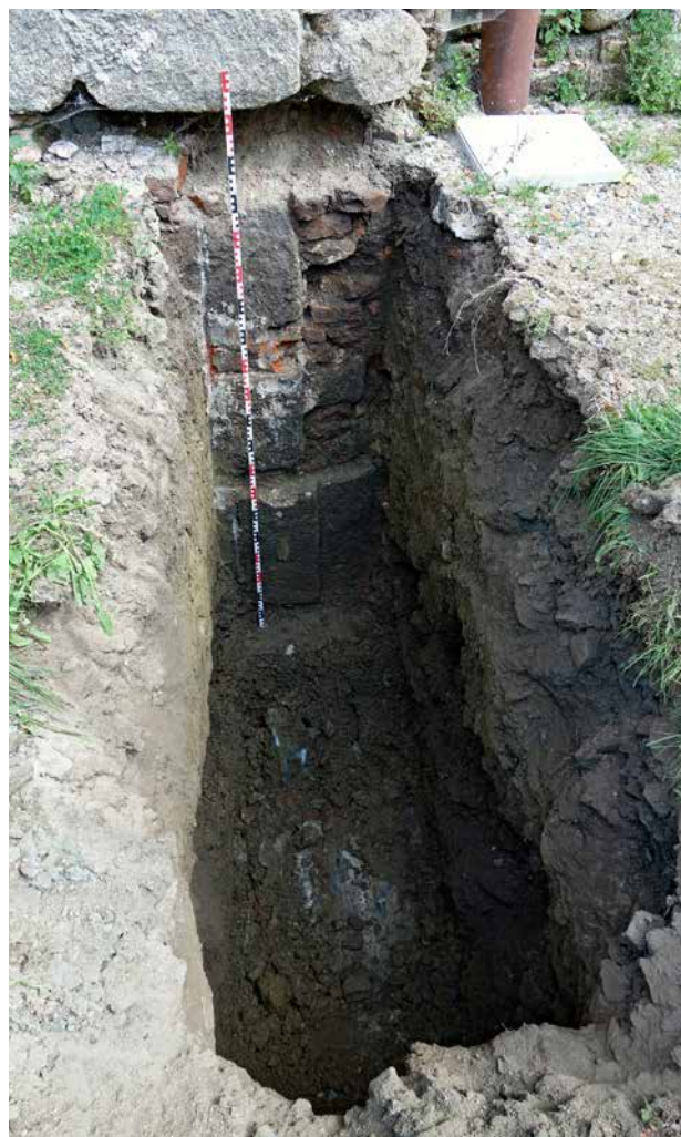
Obr. 3. Kladruby, klášter. Sonda u jihozápadního nároží saly terény. Na dně odhalen rozšířený základ stěny a profilovaný žulový sokl. Při spodní úrovni soklu byl barokní povrch terény. Pohled od západu. (Foto L. Foster, 2018)
