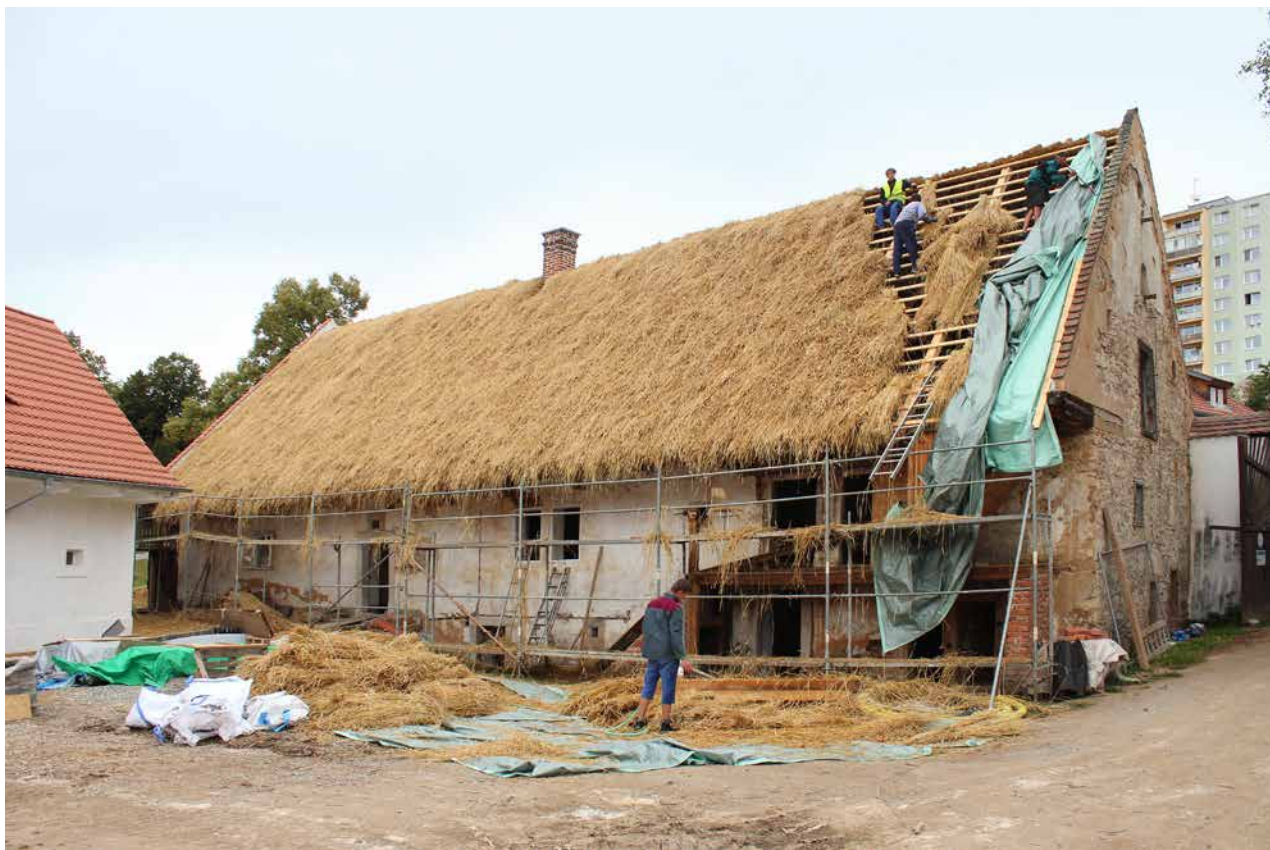
Obr. 14. Plzeň-Bolevec, selský statek U Matoušů čp. 1. Pokládka doškové krytiny střechy obytného stavení. Pohled ze dvora. (Foto K. Foud, 2020)
