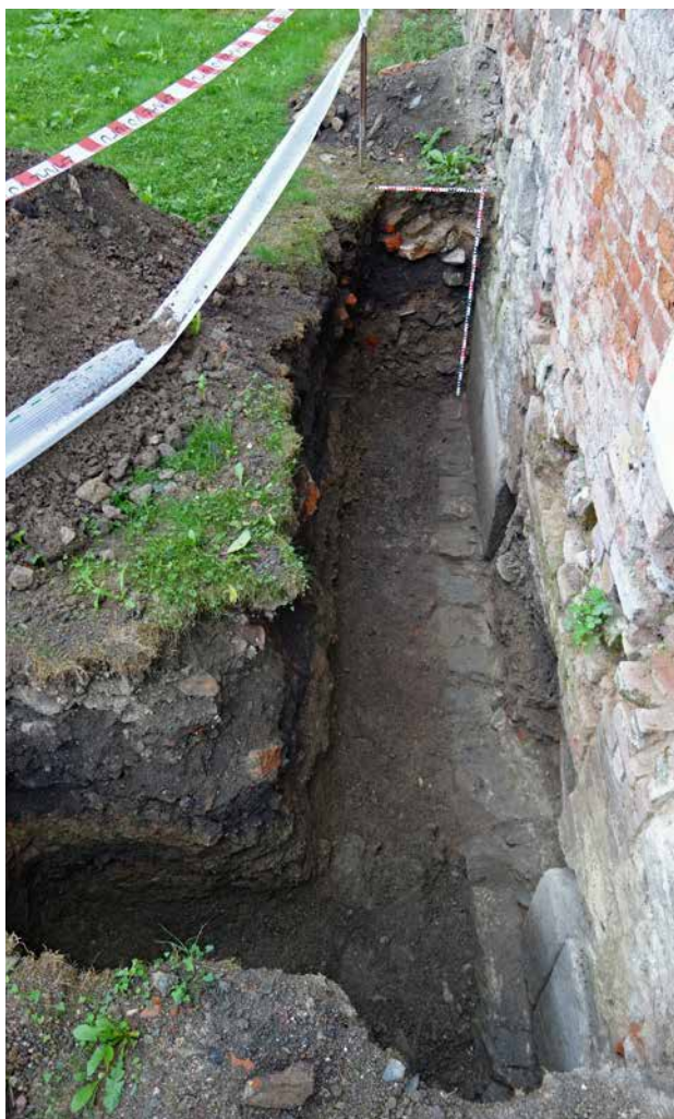
Obr. 2. Kladruby, klášter. Sonda u severní fasády saly terény. Barokní povrch terény odpovídal spodní úrovni žulového soklu, pod ním na dně sondy rozšířený základ. Pohled od západu. (Foto L. Foster, 2018)
