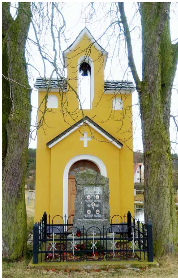
Obr. 2. Brodeslavy (okr. Plzeň-sever), kaplička, průčelí. (Foto P. Vlček, 2020)
