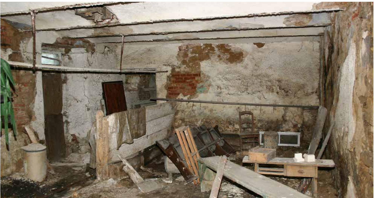
Obr. 5. Plzeň-Bolevec, selský statek U Matoušů čp. 1. Interiér chlévů v roce 2005. (Foto K. Foud)
