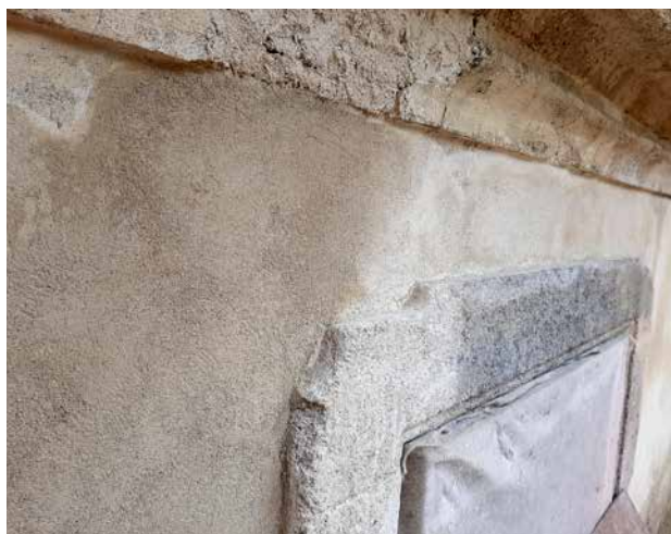
Obr. 14. Kladruby, klášter. Rajský dvůr starého konventu, postup obnovy fasády staré prelatury / východního křídla starého konventu – ponechání soudržných vrstev očištěných původních omítek a doplnění novými, stav v dubnu a květnu 2021. (Foto M. Zemanová, 2021)
