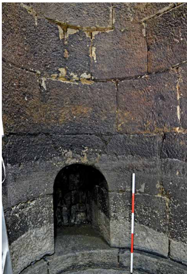
Obr. 2. Plasy, areál kláštera. Prelatura – dno vytěžené jámky. Pohled na jednu z dvojice zaslepených, nedokončených štol. (Foto M. Waldmannová, 2017)
