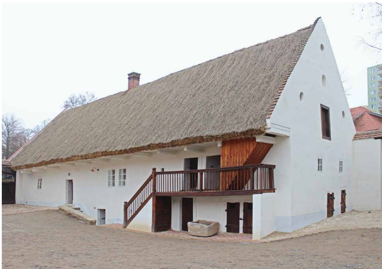
Obr. 1. Plzeň-Bolevec, selský statek U Matoušů čp. 1. Obytné stavení po obnově. Pohled ze dvora. (Foto K. Foud, 2020)
