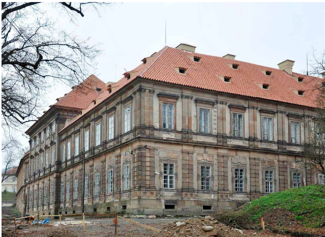
Obr. 6. Plasy, klášter. Prelatura po dokončení obnovy krovu a krytiny, pohled od jihozápadu. (Foto Z. Chudárek, 2014)
