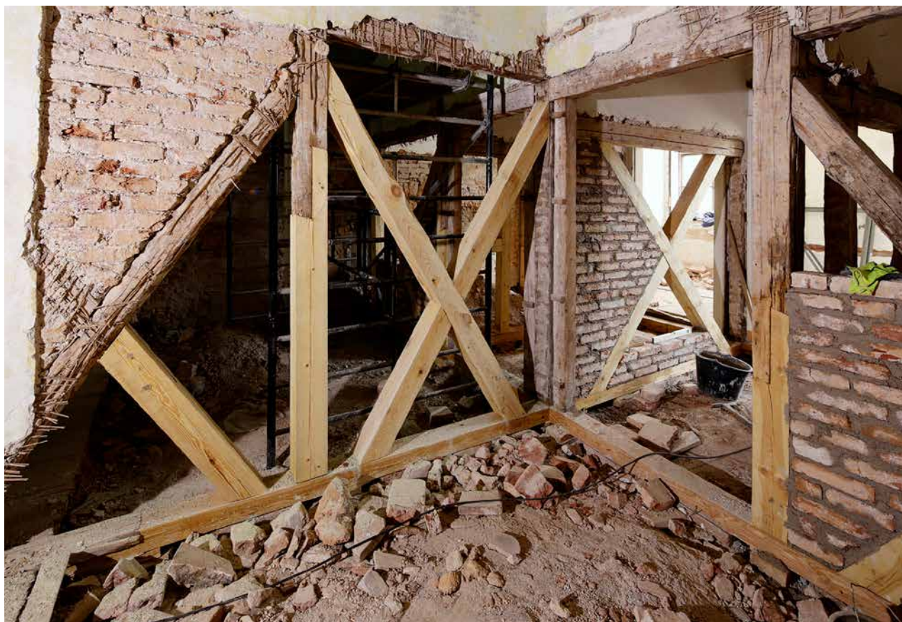
Obr. 11. Plasy, klášter. První patro prelatury, oprava hrázděných příček z třicátých let 19. století, napadených dřevomorkou. (Národní památkový ústav, generální ředitelství, foto M. Mráz, 2021)
