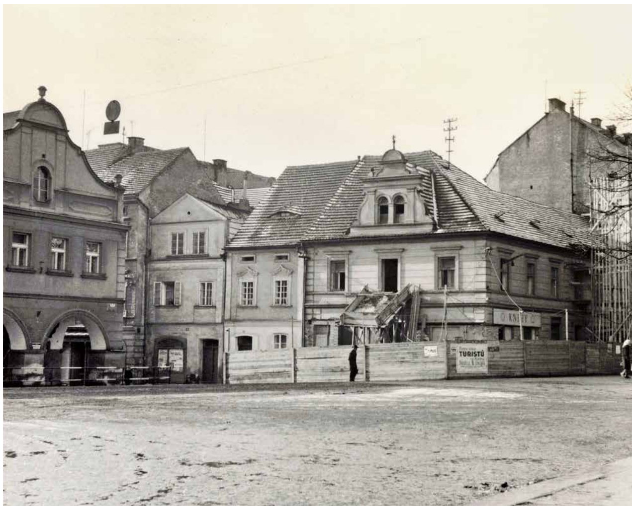
Obr. 13. Domažlice, domy čp. 99–101 před demolicí. (Foto F. Bureš, 1964)
