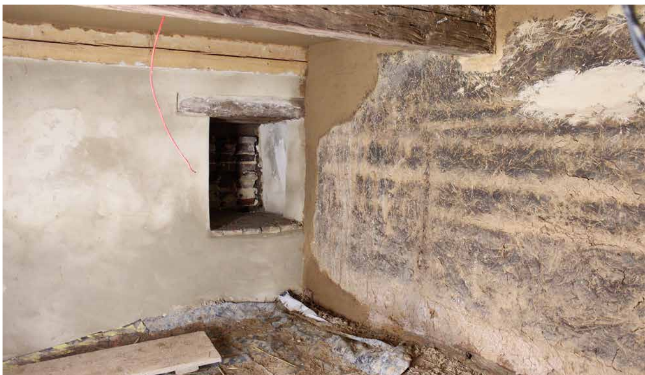
Obr. 11. Plzeň-Bolevec, selský statek U Matoušů čp. 1. Na srubové stěně zadní komory se dochovaly hliněné omítky, které byly zachovány a doplněny. Stejně bylo přistupováno i u omítek vápenných. (Foto K. Foud, 2020)
