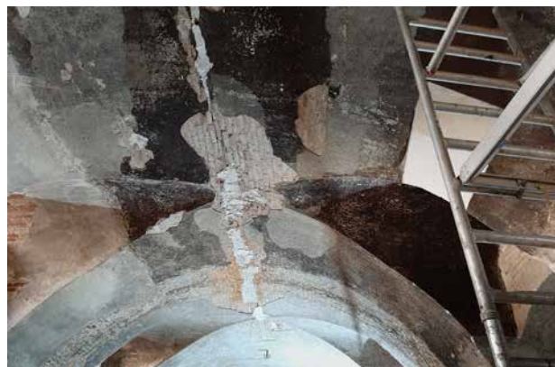
Obr. 7. Kladruby, klášter. Nový konvent, bývalá klášterní kuchyně v přízemí severního křídla. Detail stropu bývalé kuchyně v místě odbouraného dymníku. (Foto M. Zemanová, 2020)
