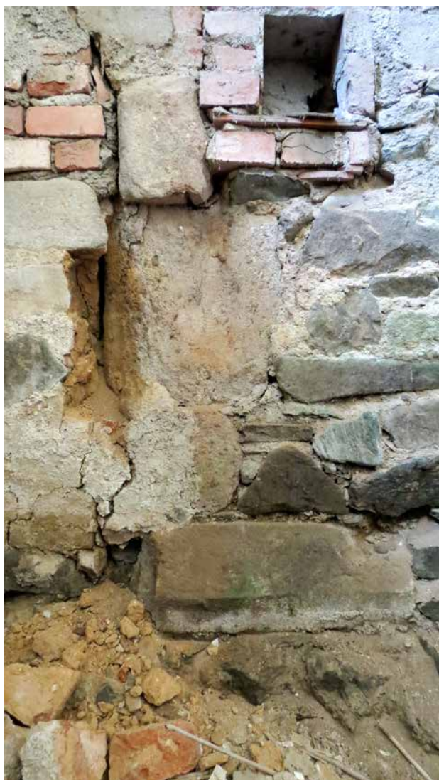
Obr. 7. Plasy, klášter. Staré opatství, přízemí, nález fragmentu armování špalety průjezdu ze 13. století, jenž umožnil základní identifikaci dispozice hostinského domu. (Foto Z. Chudárek, 2013)
