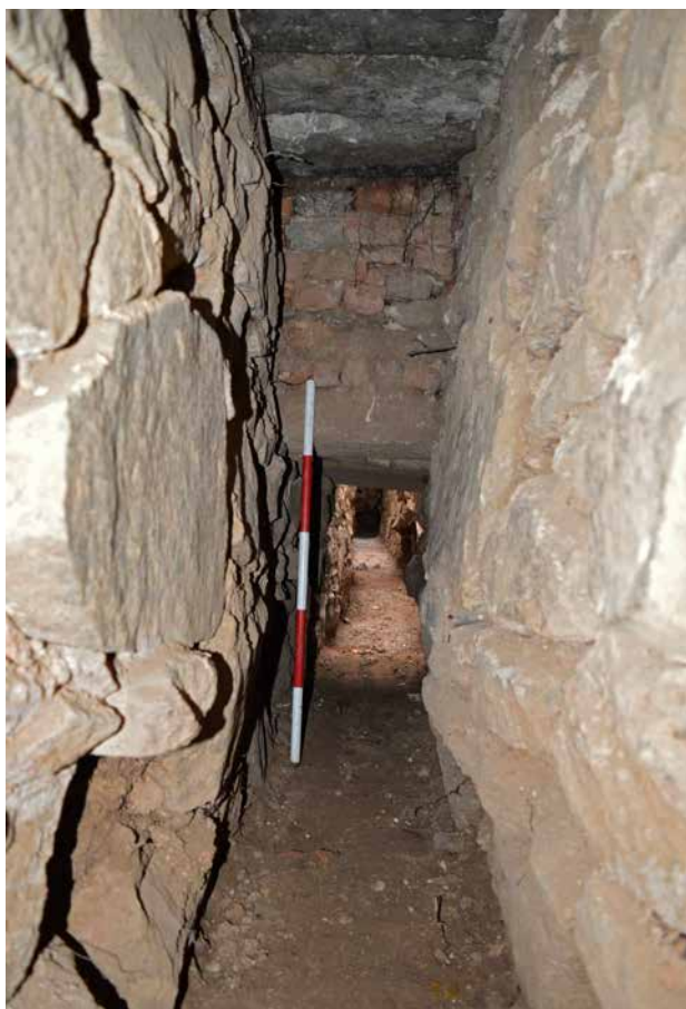
Obr. 8. Plasy, klášter, štola Q. Pohled na severní čelo konstrukce se sníženou výškou stropu. (Foto M. Waldmannová, 2019)
