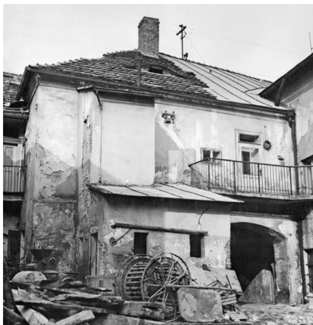
Obr. 2. Sušice (okr. Klatovy), dům čp. 52, zadní trakt někdejšího měšťanského pivovaru. Město sem přesunulo pivovar v roce 1720; pivovarský areál se rozšiřoval v zadním traktu, k největší přestavbě došlo na konci 19. století. Provoz byl ukončen v roce 1949 a v roce 1964 byla hospodářská část pivovaru a pivovarské komíny zbourány. (Foto J. Pavlíková, 1964)
