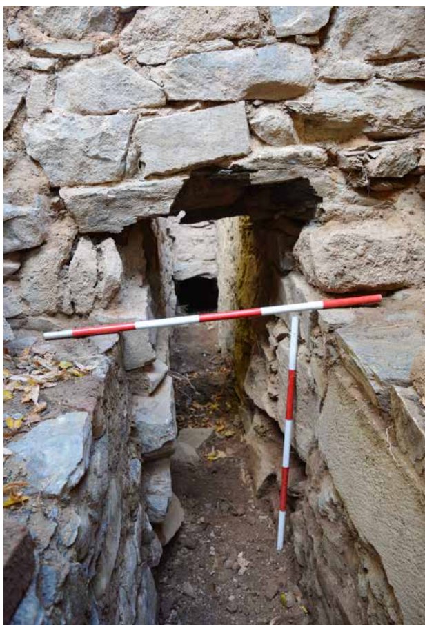
Obr. 10. Plasy, klášter, štola Q. Kolmo přes kanál přechází pozůstatek zdiva zaniklého objektu, skrz zdivo zjištěna dutina (obr. 11). Na snímku vlevo patrné dodatečné napojení boční zdi kanálu – pravděpodobně přezdiváno v rámci oprav v blíže neurčené době. Pohled od jihu. (Foto M. Waldmannová, 2019)
