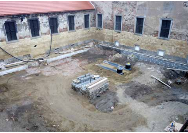
Obr. 11. Kladruby, klášter. Rajský dvůr starého konventu, pohled na dvůr - snížení „pivovarské“ přizdívky na východní (a severní) straně dvora, vybudování odvětrávacího kanálu na straně jižní (a západní), osazení nádrží pro zachytávání dešťové vody a budování základu pro kamennou nádrž ve středu dvora - stav obnovy v říjnu 2020. (Foto M. Zoubek, 2020)
