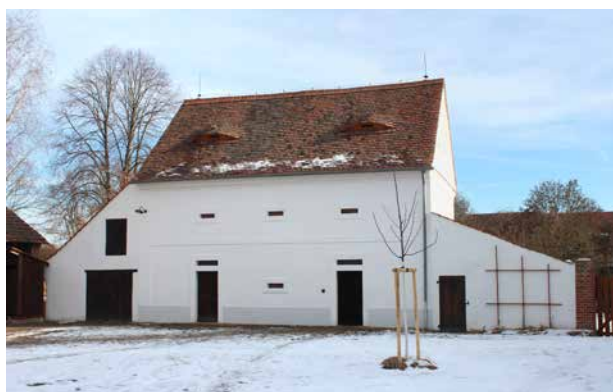
Obr. 8. Plzeň-Bolevec, selský statek U Matoušů čp. 1. Sýpka, pohled ze dvora, stav po obnově. (Foto K. Foud, 2021)
