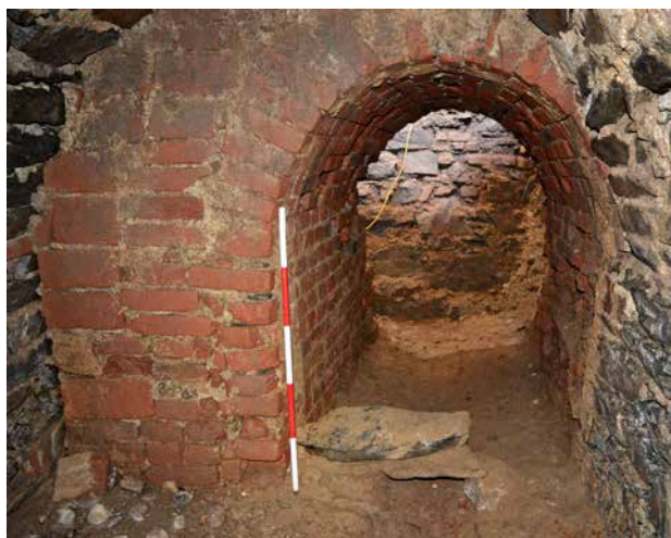
Obr. 17. Plasy, klášter, štola Q. Pohled do závěrečné části štoly Q2 od jihozápadu – za sklepem následuje cihelně zaklenutý zúžený „krček“. Pokračující situace byla zrušena vložением základu barokního ambitu (zeď na snímku vzadu). (Foto M. Waldmannová, 2018)
