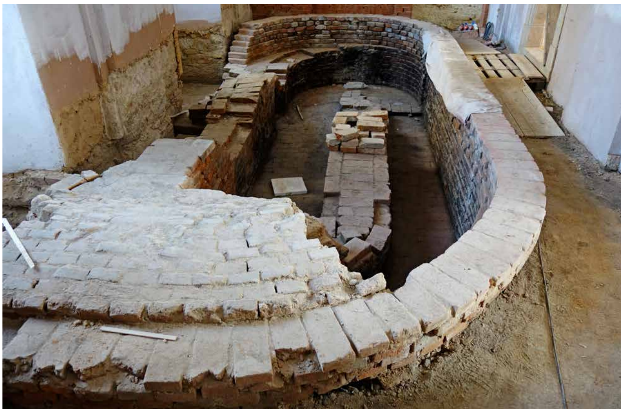
Obr. 6. Klášter Kladruby. Nový konvent, základ kotelny pro ohřev vody parního stroje pivovaru, ambitová chodba ve východním křídle. (Foto M. Zoubek, 2021)
